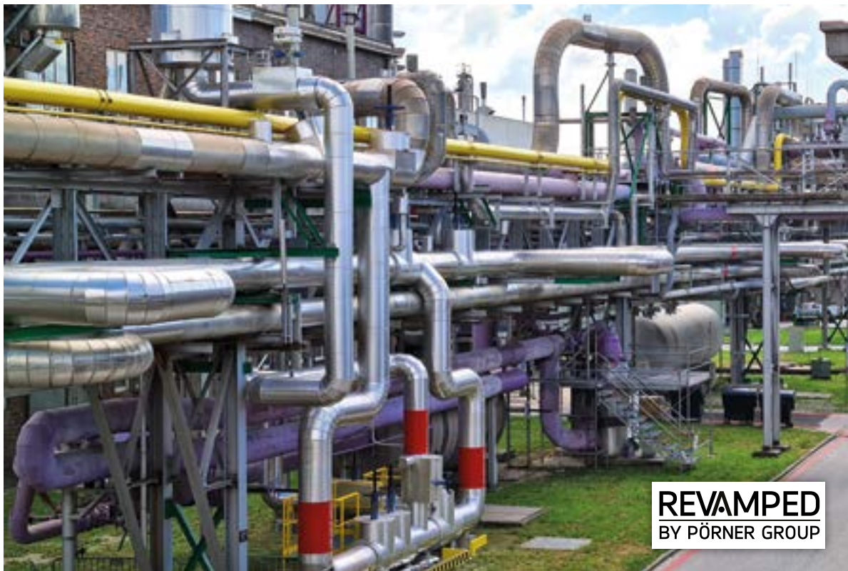
Nach der Final Study aus 2015/2016 und Beginn der „Execution Phase“ 2018 wurden die beiden Projekte zur Modernisierung „on time“ abgeschlossen.
