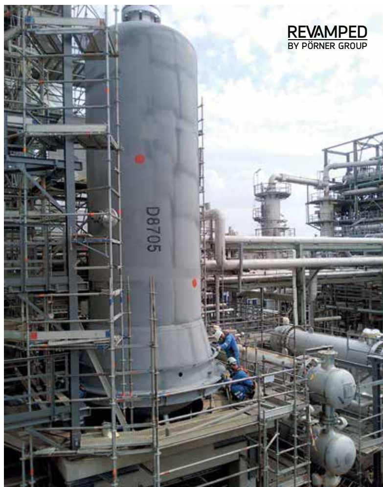
Благодаря грамотному проектированию, реактор весом 55 т идеально смонтирован на фундаменте
