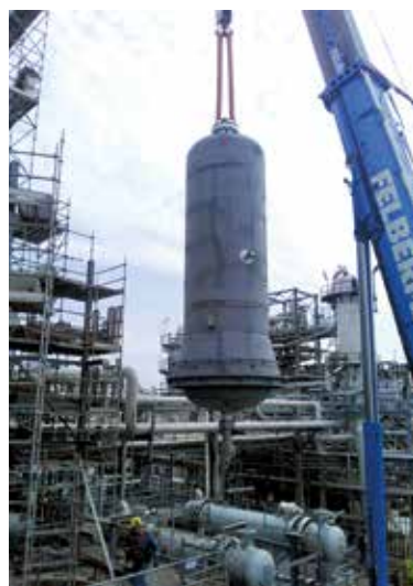
Монтаж нового реактора в период останова в июне 2020 г.
