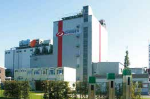
Установка по производству 15 000 т/год топлива и 2,3 МВт электроэнергии из 65 000 т/год древесины, на основе пиролиза, газификации, очистки и подготовки синтез-газа, синтеза Фишера-Тропша; производство электроэнергии и кислорода, построена в 2007г.
