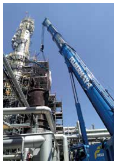
Демонтаж реактора, срок службы которого подошел к концу
