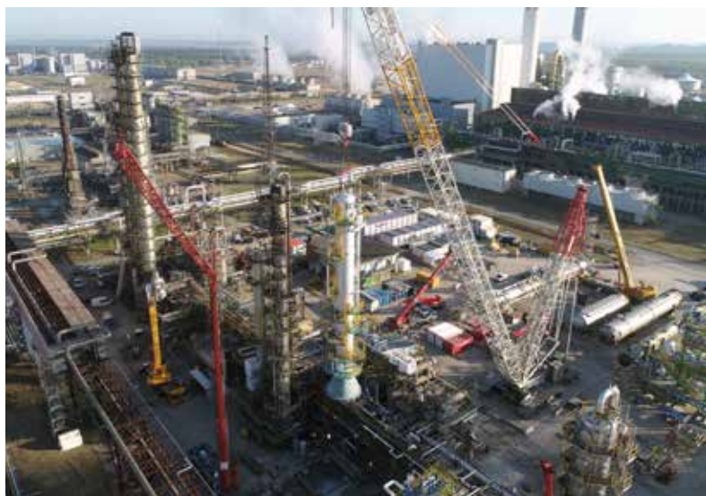
Монтаж новой экстракционной колонны в идеальных погодных условиях в апреле 2020
