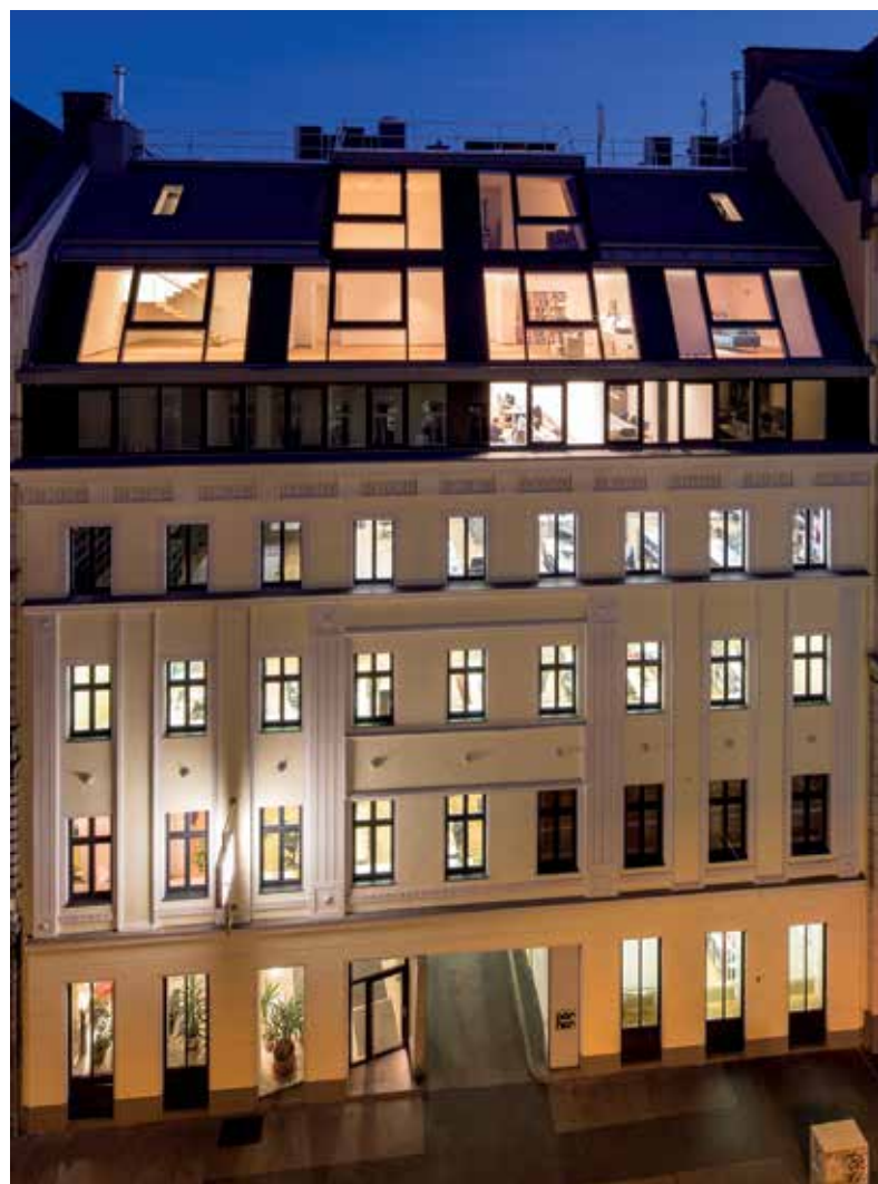
Die Pörner Zentrale in Wien verfügt nun über drei neue Stockwerke.
