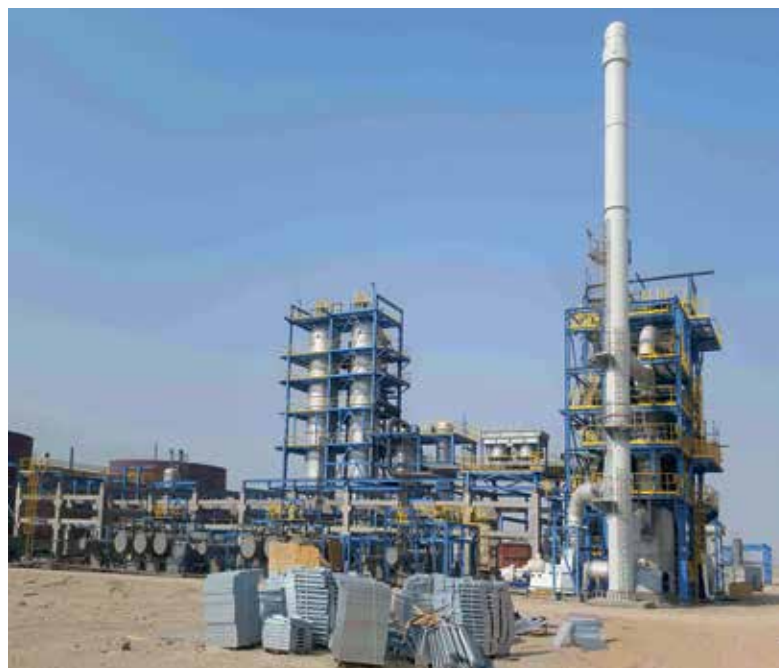
Fünf Biturox®-Anlagen wie diese im Irak sind derzeit „under construction“.
