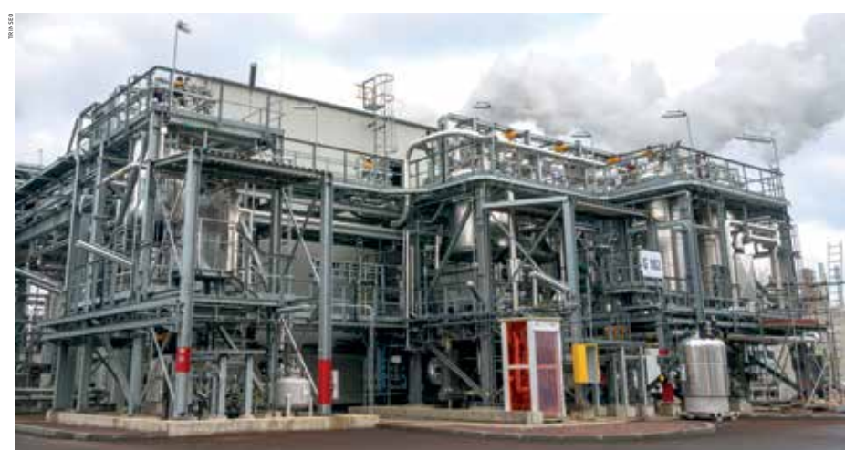
S-SBR-Pilotanlage zur Produktion neuer Kautschuk-Werkstoffe für Hochleistungsreifen
