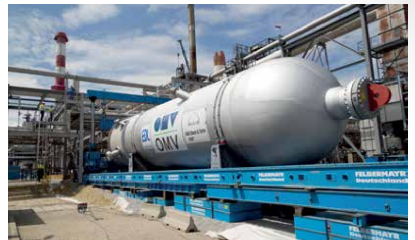
Mit nur 8 cm Toleranz wurde der Reaktor auf einer speziellen Hydraulikvorrichtung unter einer Rohrbrücke hindurchgeschlittet.
