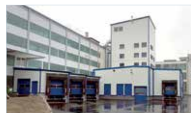
Die Bauzeit für das Gebäude der neuen Mischanlage inklusive der LKW Verladestation betrug sechs Monate.
