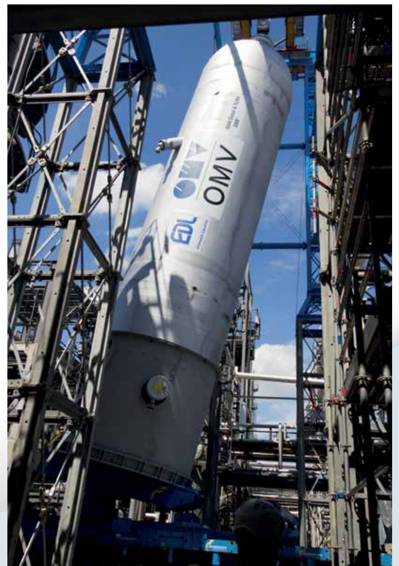
Ein erhebendes Erlebnis: der neue HDS3-Reaktor wird aufgerichtet und kann ohne Nachjustierung auf das Fundament gesetzt werden.
