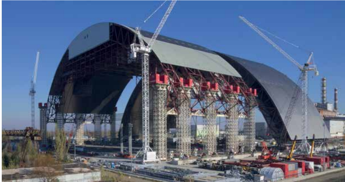
Die Arbeiten an der Sicherheitsüberdachung über dem havarierten Reaktor schreiten voran.
