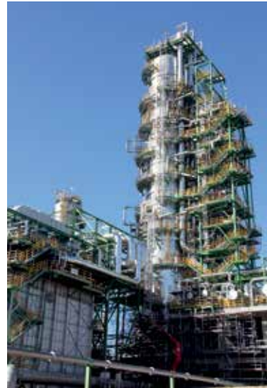
Termingetreue mechanische Fertigstellung der Vakuumkolonne im Rahmen des Stillstands „Kleiner 16“, mit einer Höhe von 71 m und insgesamt 760 t Gewicht
