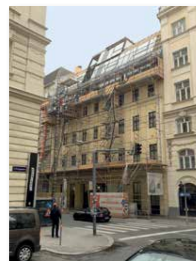
Baustelle in der Hamburgerstraße in Wien
