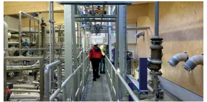
Die beengten Raumverhältnisse der Nassderivateanlage.
