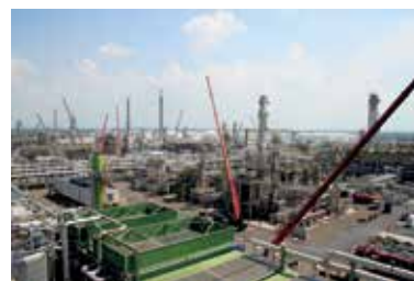
Ein Raffineriestillstand erforderte ein hohes Maß an Koordinierung der verschiedenen Projekte zur selben Zeit.
