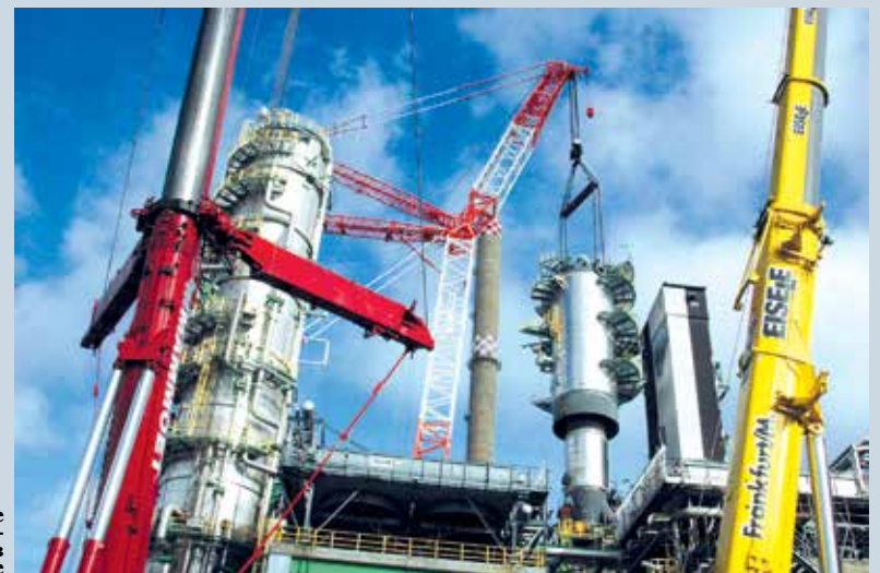
Применение мощных грузоподъемников при монтаже
