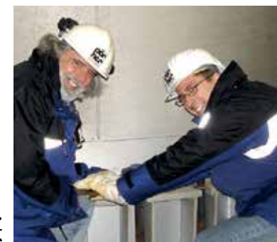
Специалисты «Пернер» выполняют монтаж реактора на стройплощадке
