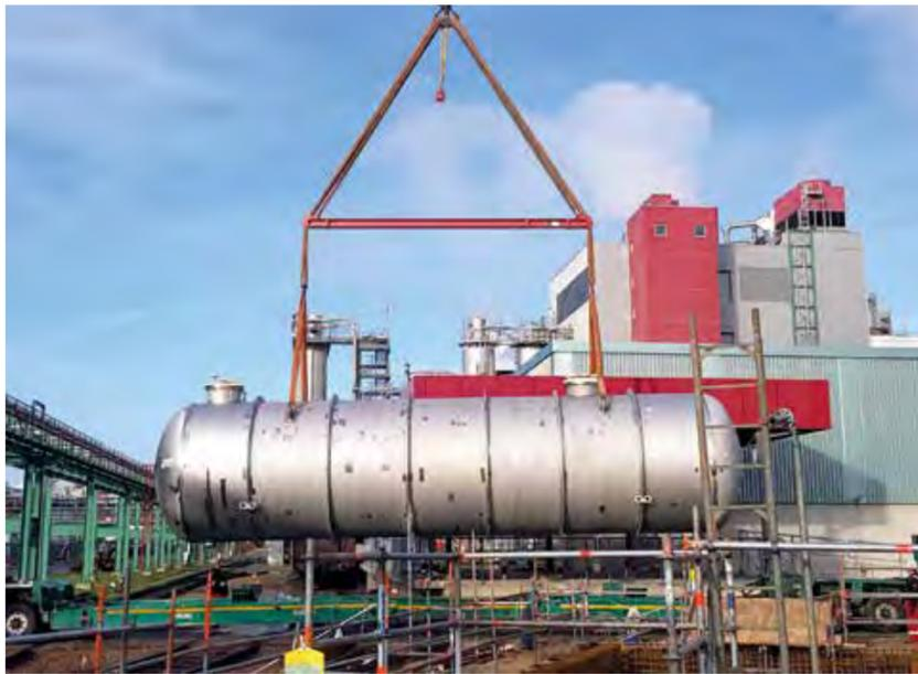
Der neue doppelwandige 100 m<sup>3</sup>-Ethylenoxid-Tank wird eingehoben.
