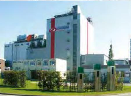
**Anlage zur Herstellung von 15.000 t/a Kraftstoff und 2,3 MW Strom aus 65.000 t/a Holz, basierend auf Pyrolyse, Vergasung, Synthesegasreinigung und -konditionierung, Fischer-Tropsch-Synthese, Strom- und Sauerstofferzeugung, gebaut 2007**
