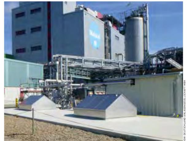
**o.:** Der Ethylenoxid-Tank ist in der Erde verlegt und sicher abgedeckt. Der letzte Schritt im Gesamtprojekt ist abgeschlossen! Eine reduzierte Anzahl von Ethylenoxid-Verladungen aus Kesselwagen in dem neuen unterirdischen Ethylenoxid-Tank führt zu einer geringeren Gefährdung im Gesamtbahnverkehr, da weniger Kesselwagen mit Gefahrgut transportiert werden.
