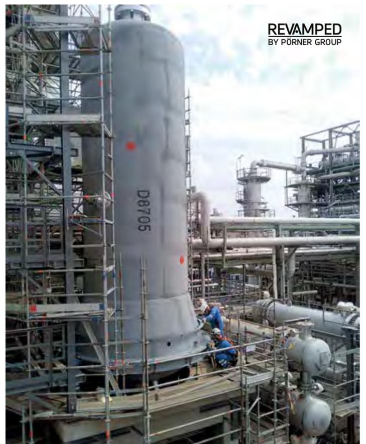
Dank guter Planung passt der 55 Tonnen schwere Reaktor perfekt auf das Fundament. Der gesamte Austausch der Ausrüstung geht problemlos vonstatten.
