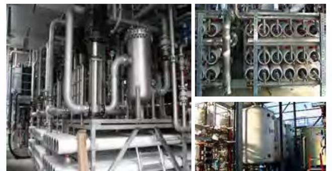
Aufbereitung von Flusswasser zu Kesselspeisewasser mittels Ultrafiltration, Kationentauscher zur Dekarbonisierung, Umkehrosmose, CO<sub>2</sub>-Entgasung und abschließendem Multistep-Ionentauscher mit der Durchsatzleistung von 300 m<sup>3</sup>/h (Ausbaustufe 1) und 100 m<sup>3</sup>/h (Ausbaustufe 2). Durchführung im Auftrag von Siemens
