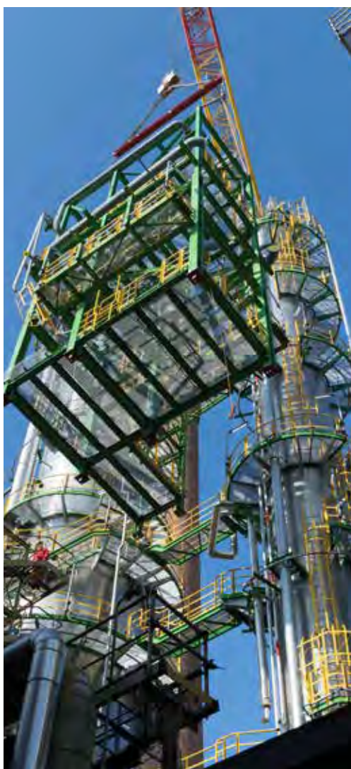
Поднимается новая колонна К3 установки сырой нефти 3
