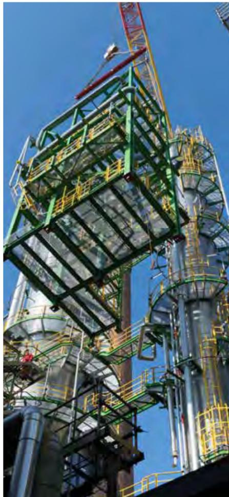
Neue Kolonne K3 der Rohöl3-Anlage wird eingehoben
