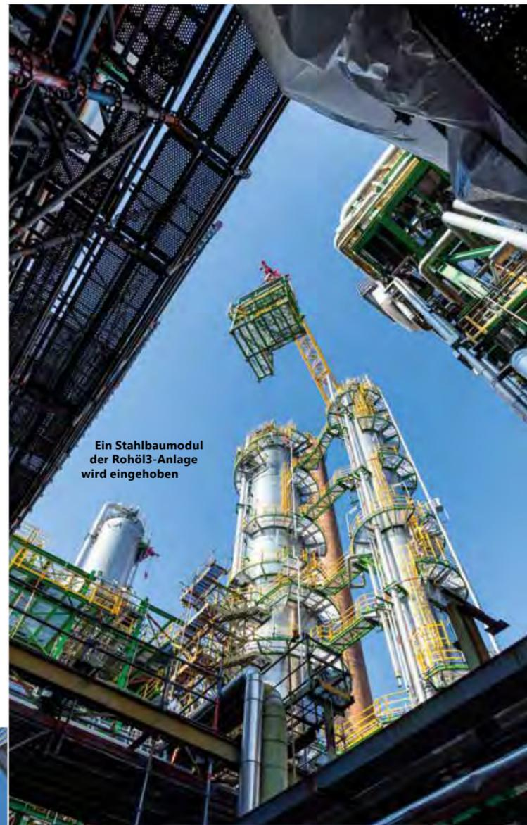
Ein Stahlbaumodul der Rohöl3-Anlage wird eingehoben
